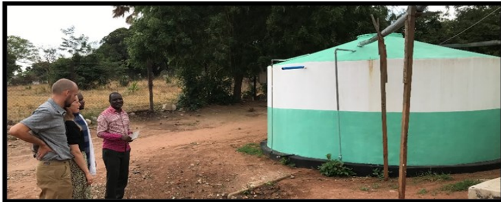
Sygehusets Vandtanke i Sikonge renoveres
