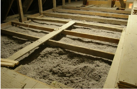
Isolering under gulvbrædder på loftet
